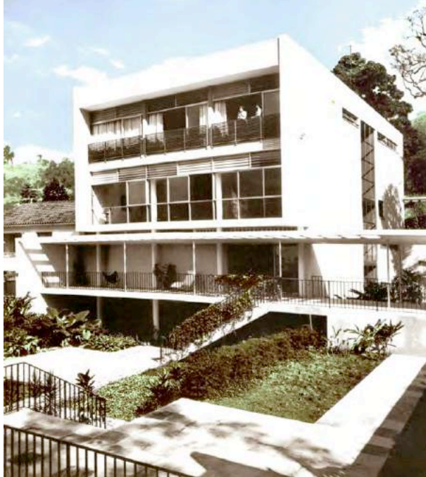
Figura 17: Fachada da casa modernista projeto de Jorge Moreira de 1951
