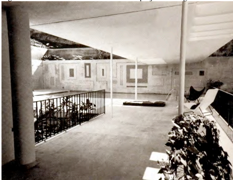
Figura 18: Área interna da casa modernista projeto de Jorge Moreira de 1951
