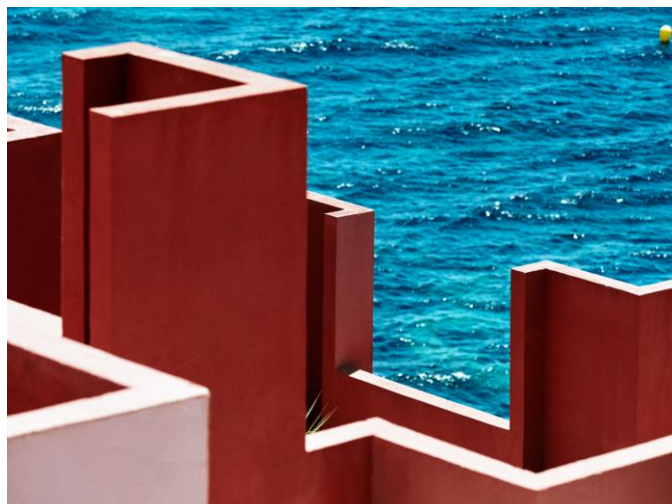
Figura 2. La Muralla Roja. 1968-1973. Calpe. Vista de los acabados altos del edificio
