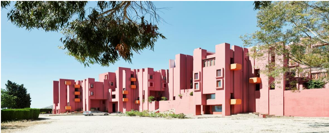
Figura 1. La Muralla Roja. 1968-1973. Calpe. Panorámica del exterior de La Muralla Roja
