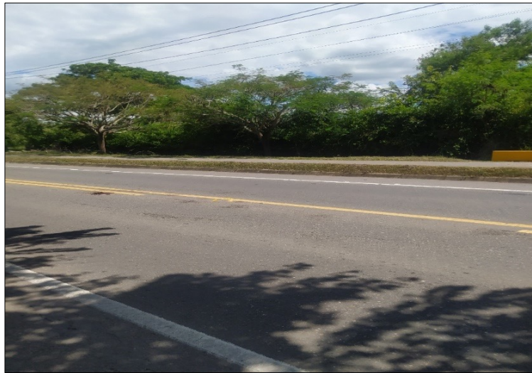
Figura 4. Cruce vial sobre el kilómetro 8 – 10.
