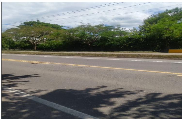
Figura 3. Cruce vial sobre el kilómetro 8 – 10.
