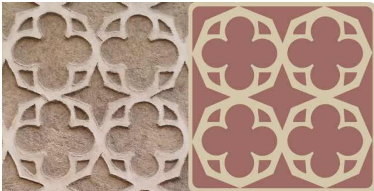
Figura 2. Detalle de esgrafiado en Calle Marqués del Arco, 5 junto a Catedral de Segovia, y su versión vectorizada.
