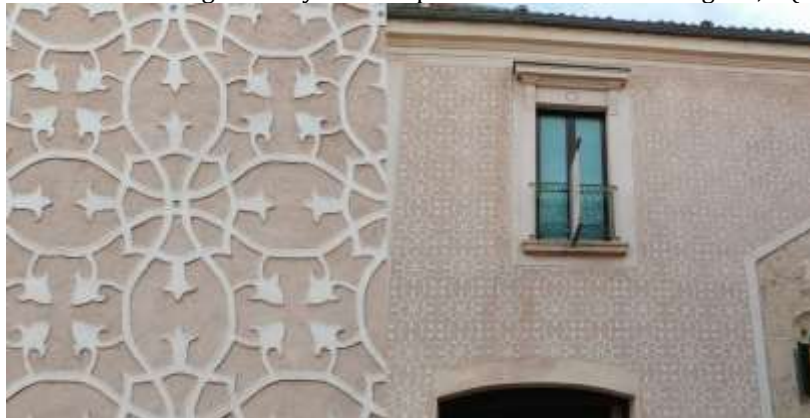
Figura 12. Detalle de esgrafiado y fachada presente en Calle Valdeláguila, 7 (Segovia)
