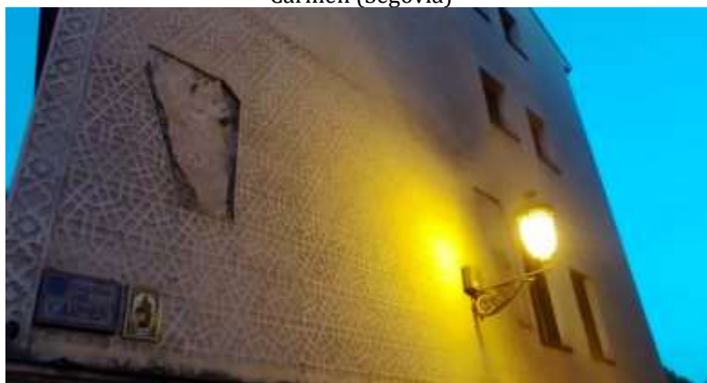
Figura 10. Cata donde se muestra el esgrafiado original y su restauración posterior, en Calle Bajada del Carmen (Segovia)
