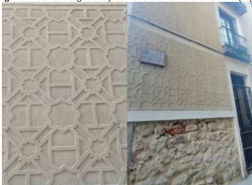
Figura 1. Detalle de esgrafiado y fachada sita en Calle de la Herrería (Segovia)
