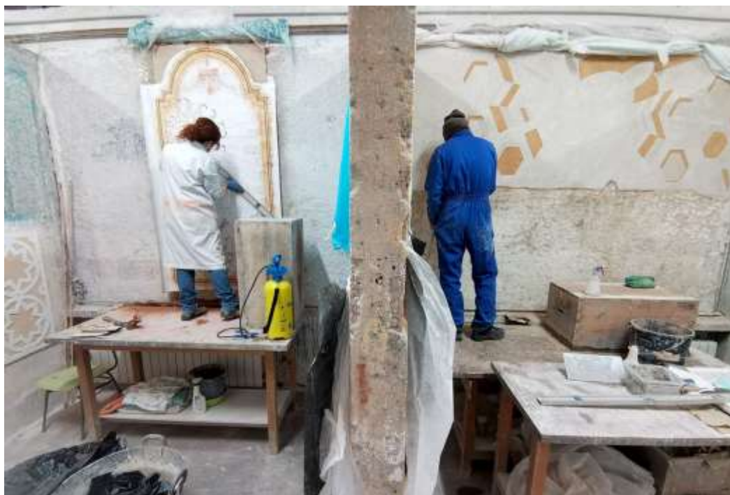
Figura 3. Uso de plantillas para esgrafiado en la Escuela de Arte Casa de los Picos (Segovia)
