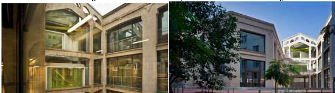
Imagen 12: Rehabilitación arquitectónica de la Serrería Belga
