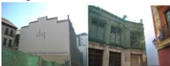
Imagen 3: La Serrería en obras 2000-2004
