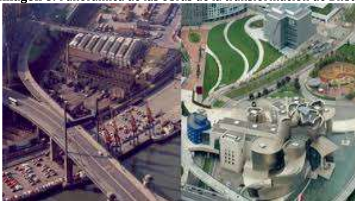
Imagen 6: Panorámica de las obras de la transformación de Bilbao
