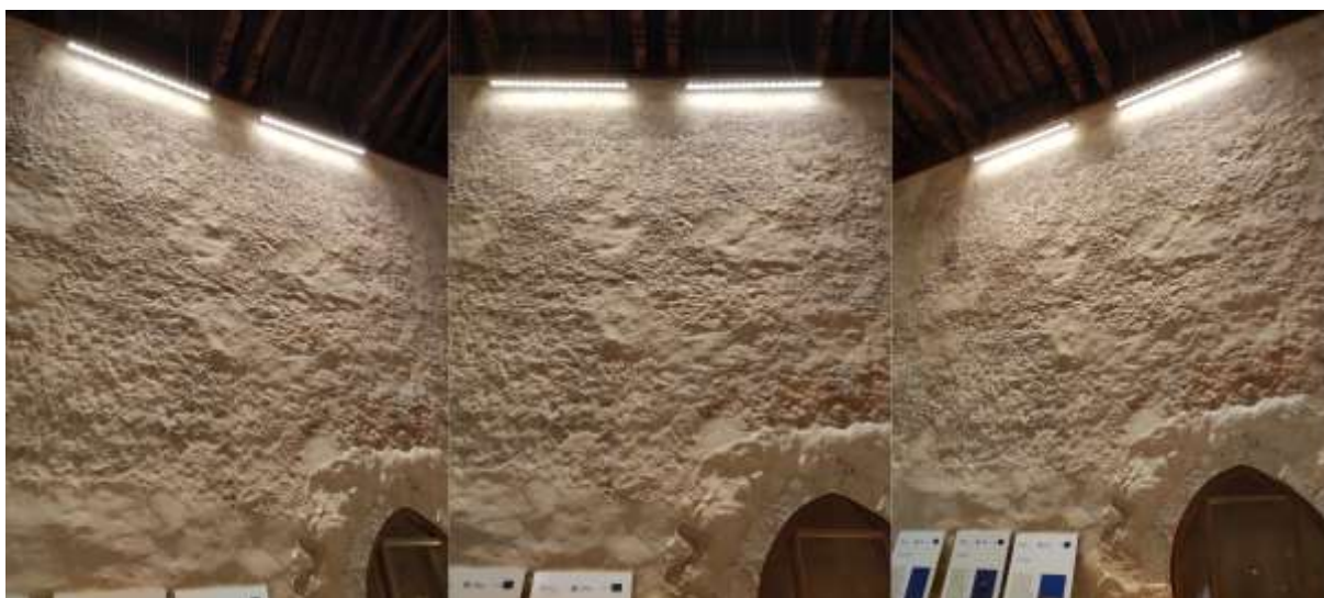
Figura 7. Múltiples ángulos del muro norte
