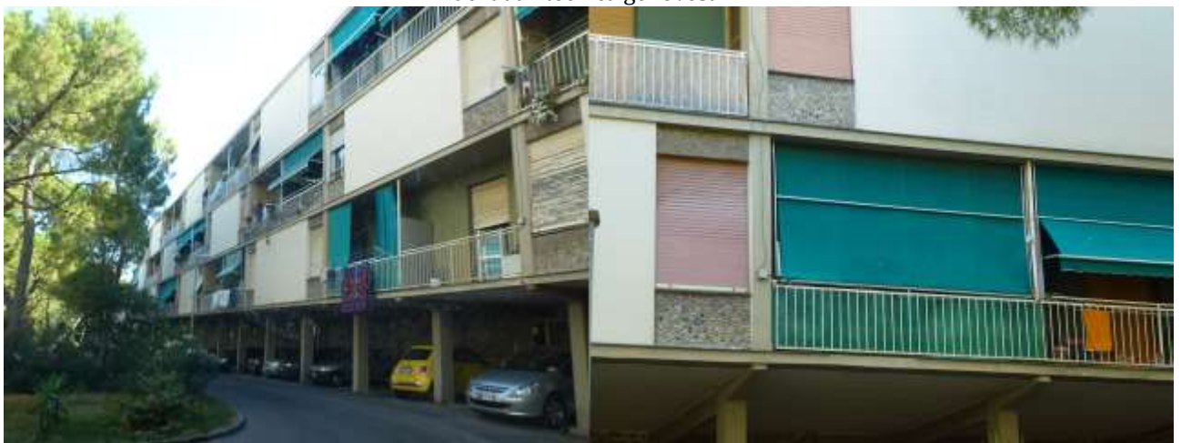
Figura 7. Fotografías de los edificios del Complejo Bernabò Brea (Génova) sobre pilotis. Acabados de la fachada «técnica genovesa»
